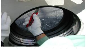
※マンホール内側へのはみ出し及びモルタル 仕上げ部(内目地)が少なく剥がれる危険性が ある場合カッターなどでゴム部を切り落として下さい。
